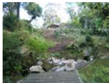
永山城跡の被災状況
