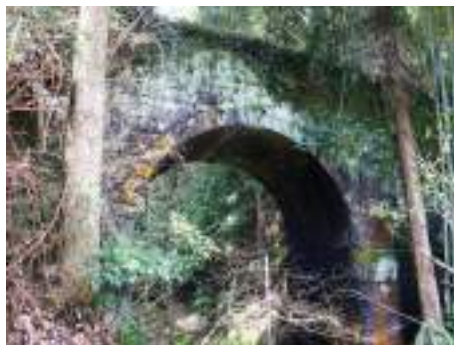
高井町の逆谷橋
