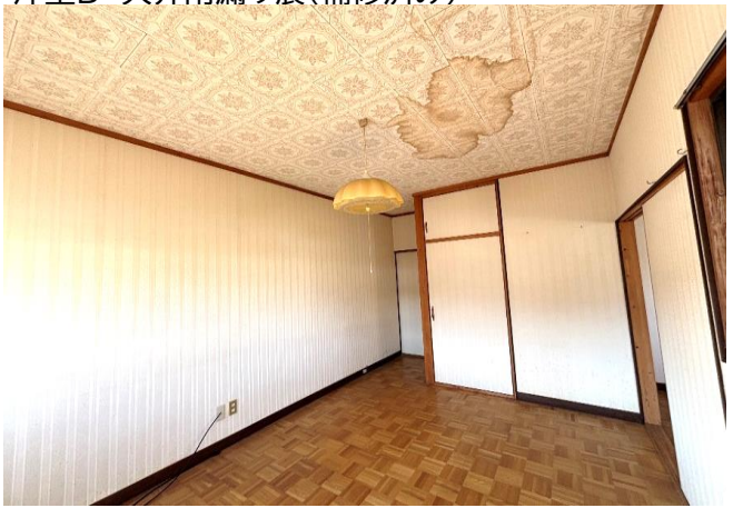
2F和室 天井雨漏り痕(補修済み)
