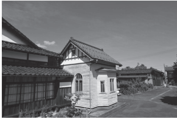
現在の長善館建物 昭和9（1934）建築
