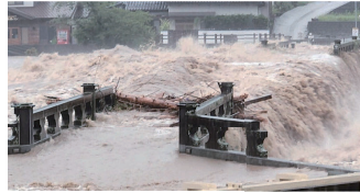
令和5年7月10日洪水(耶馬溪橋)
