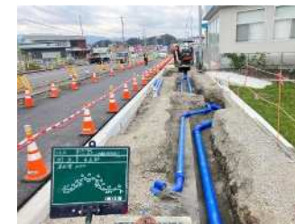
③ 水道管移設工事
