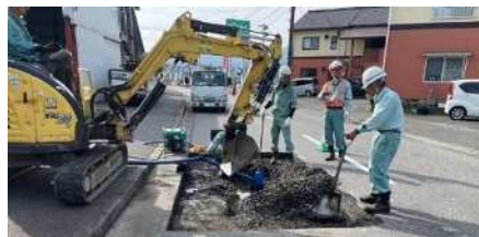
② 漏水したところの補修
